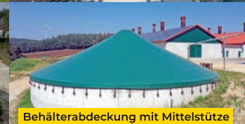
Behälterabdeckung mit Mittelstütze
