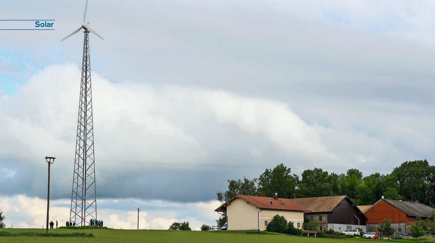
△ Kleinwindräder dienen vor allem der Eigenstromversorgung. Darum sollten nicht zu weit weg vom Hof stehen.
