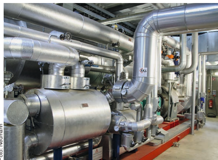
◀ Erdgas-turbinen wie diese könnten nach Ansicht der Ampelparteien eine Brückentechnologie sein.
