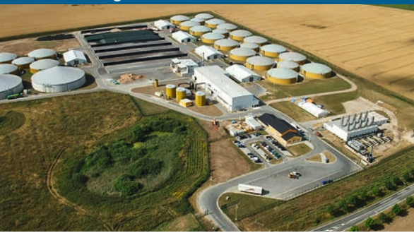
◁ Im Biogas-park in Güstrow steht die erste integrierte Bio-LNG-Anlage.
