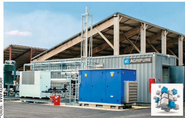
△ Mit agripure können Betreiber Biogas zu Biomethan veredeln.
